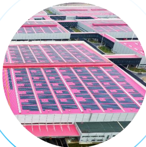
工商业光伏电站
