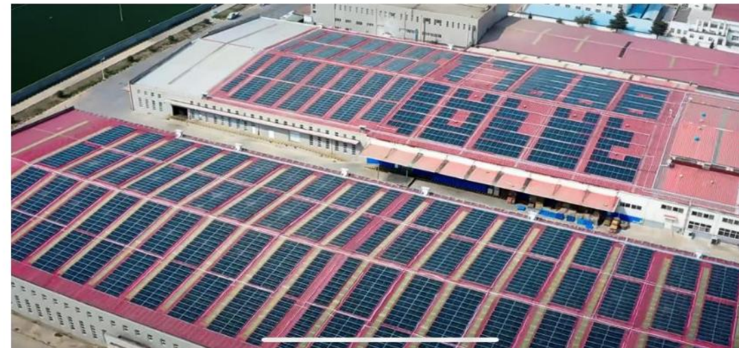
白象食品2.1MW工商业光伏项目
