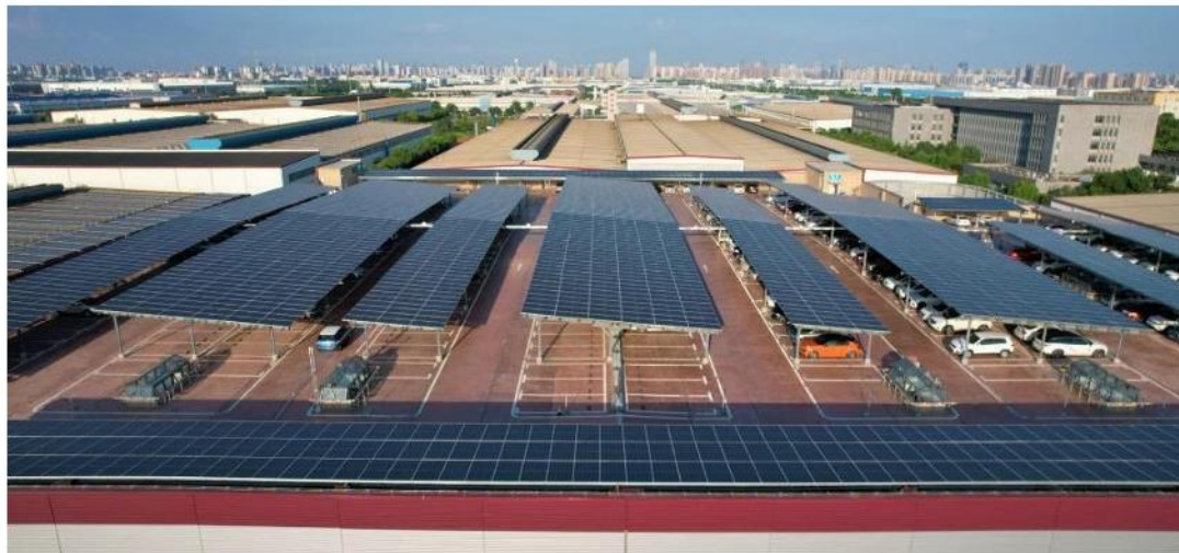
合力叉车8.21MW工商业光伏项目
