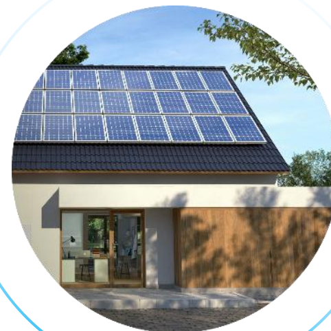
家庭光伏电站
