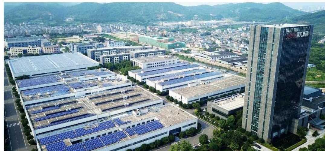
得力集团9.2MW工商业光伏项目
