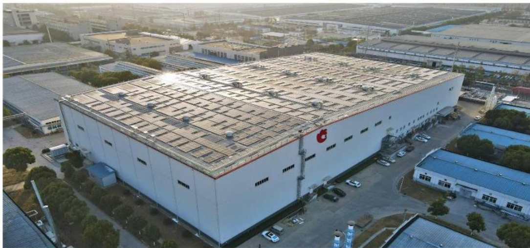
洽洽食品1.36MW工商业光伏项目
