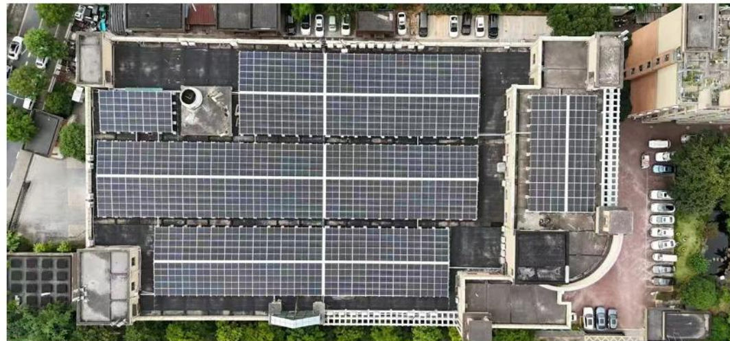
浙江省杭州市余杭区未来科技城光伏项目
